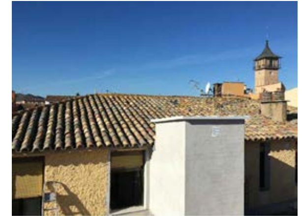
Vista actual cubierta 2
