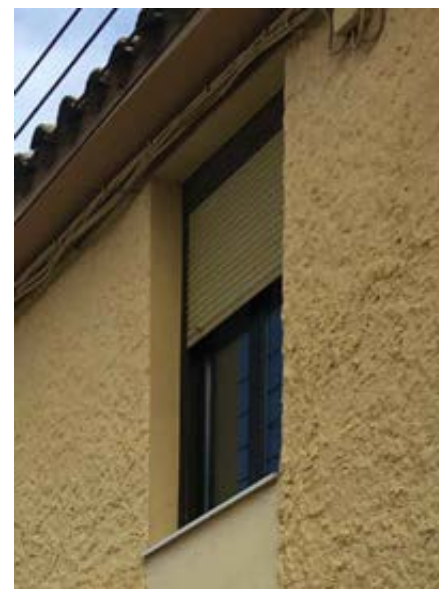
Vista carpintería planta primera
