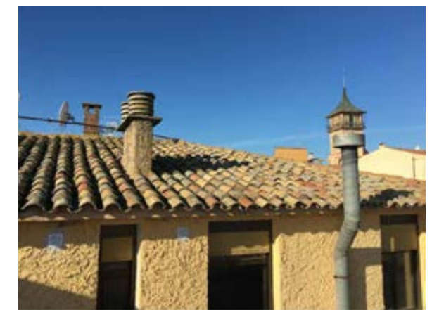
Vista actual cubierta 3
