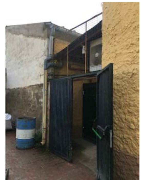
Vista actual acceso secundario
