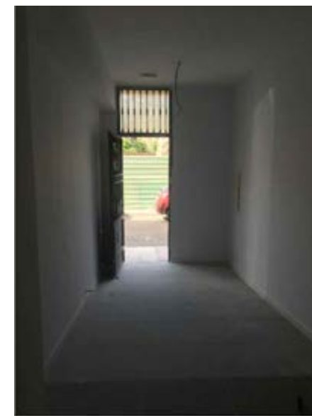
Vista actual interior del acceso principal.
