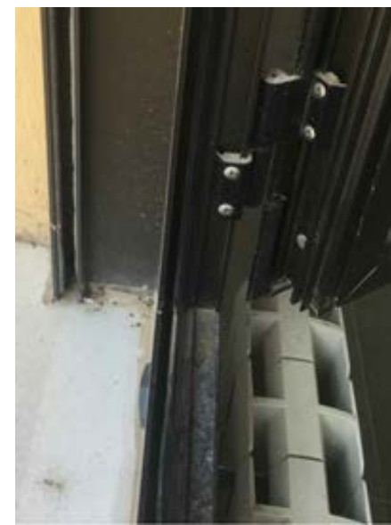
Vista actual carpintería existente
