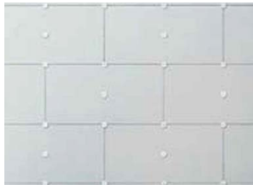
DETALLE COLOCACIÓN DE AISLAMIENTO EPS
