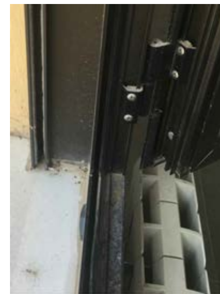
Vista actual carpintería existente
