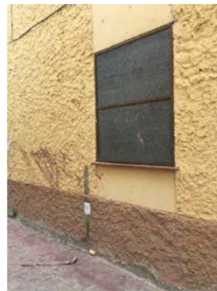
Vista 2 actual hueco de ventana tapiado alzado lateral 1
